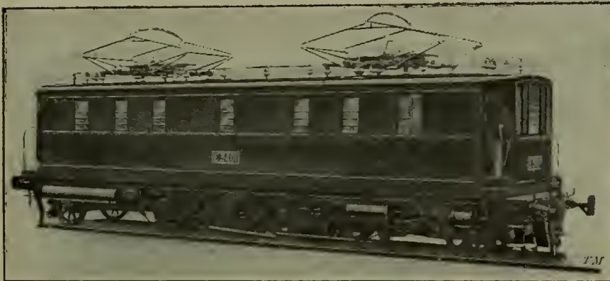
Fig. 146. — Vue de la locomotive électrique de 1500 ch. à courant monophasé.
